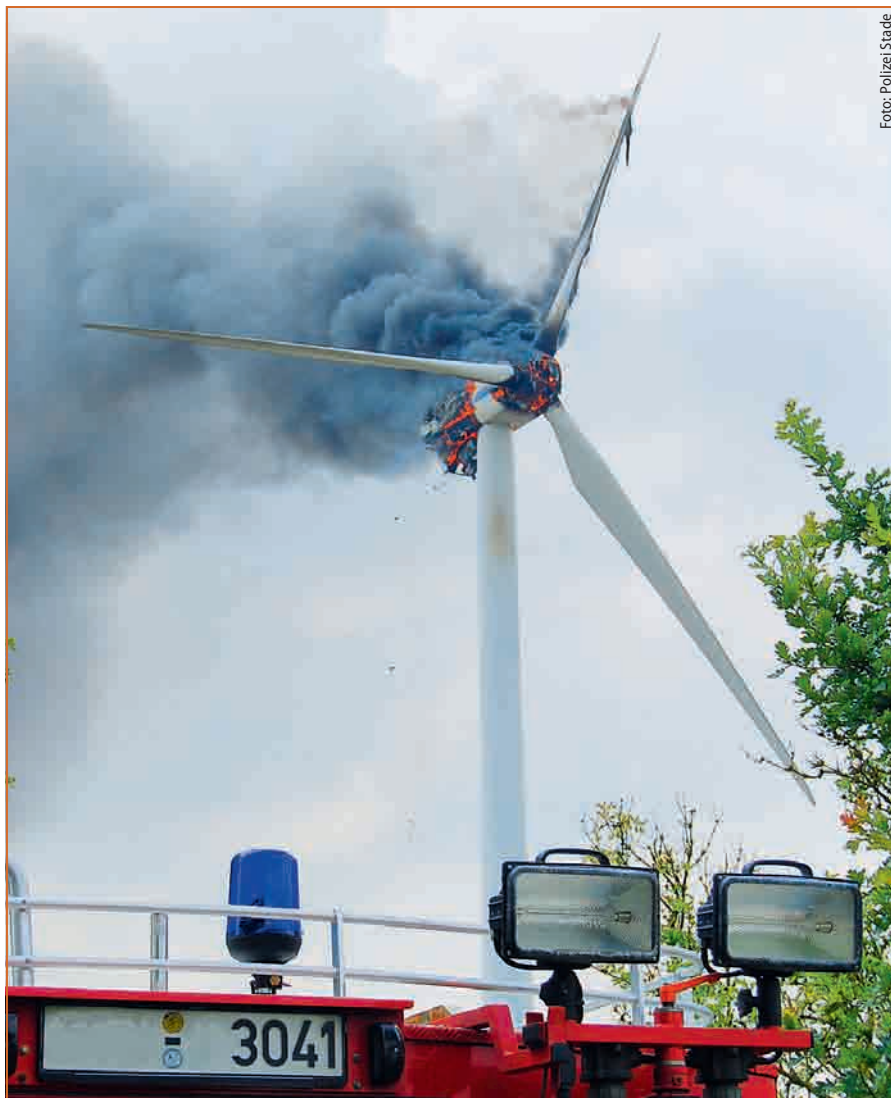
Abb. 2: Brennendes Maschinenhaus einer WEA
